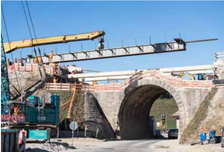
Les deux poutres ont été posées au-dessus de l'actuel pont des Petites-Crosettes. NICOLAS MONTANDON
